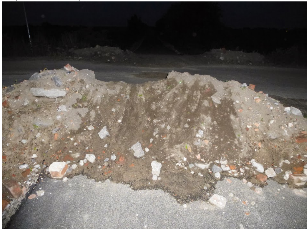
A tak wygląda ślad drogi od strony Świerczynek - kompletnie nic nie zostało zrobione, nawet usunięcie chaszczy i podbudowa:
